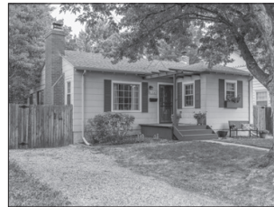
1545 S. COLUMBINE ST
