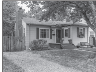
1545 S. COLUMBINE ST
